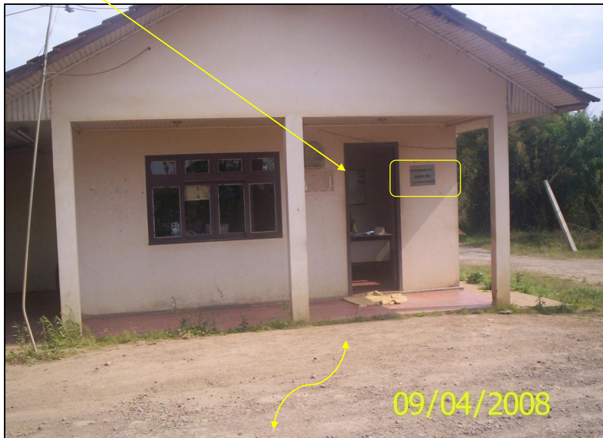
FOTOGRAFIA 2-UV – SÃO MATHEUS DO SUL-PR – PFS FIXO DIVISA – FOTOGRAFIA À ESQUERDA E À DIREITA: Aspecto da estrutura física externa.
