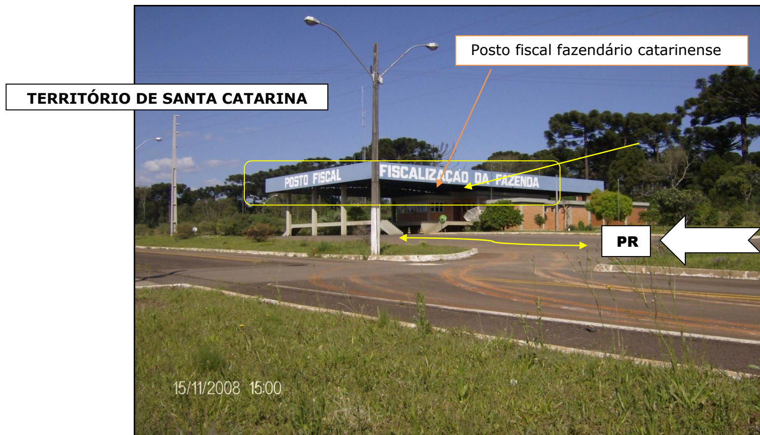
FOTOGRAFIA 2.1-PB – ABELARDO LUZ-SC – PFS FIXO RINCÃO – TERRITÓRIO DE SANTA CATARINA – Aspecto da estrutura física externa do posto fazendário da Secretaria de Estado da Fazenda de Santa Catarina.
