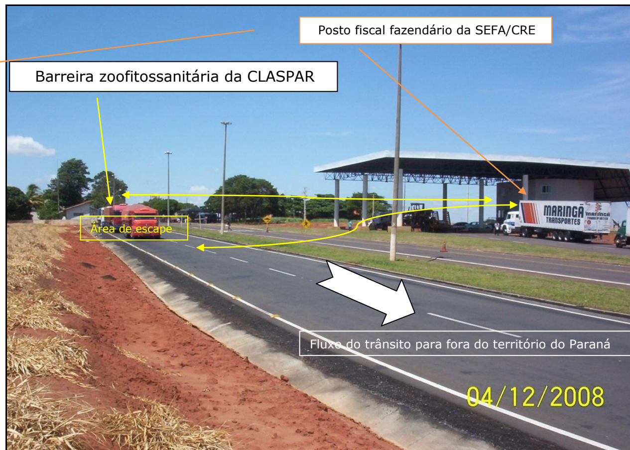
FOTOGRAFIA 1.3-MG – SANTO INÁCIO-PR – PFS FIXO SANTO INÁCIO – FOTOGRAFIA À ESQUERDA: Aspectos do posto de fiscalização fazendária da SEFA/CRE; FOTOGRAFIA À DIREITA: Situação das duas estruturas físicas fixas paranaenses, sendo que a barreira zoofitossanitária está na contramão do trânsito de veículos transportadores de cargas de interesse zoofitossanitário (e de insumos agrícolas).
