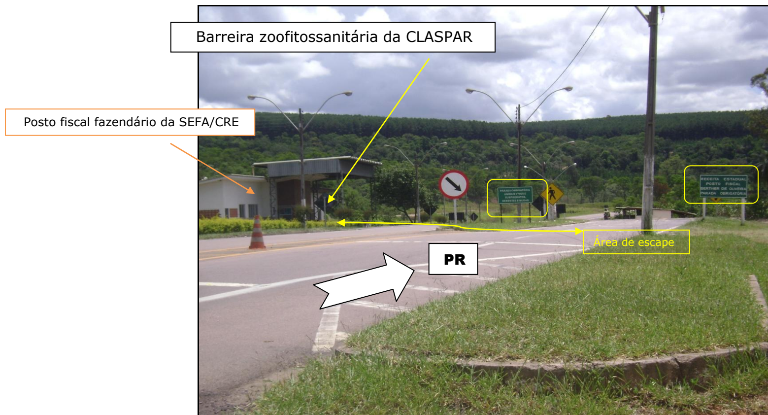
FOTOGRAFIA 1.1-PG – SENGÉS-PR – PFS FIXO BERTHIER DE OLIVEIRA – Sem área de escape com espaço seguro e adequado à interceptação dos veículos transportadores de cargas de interesse.
