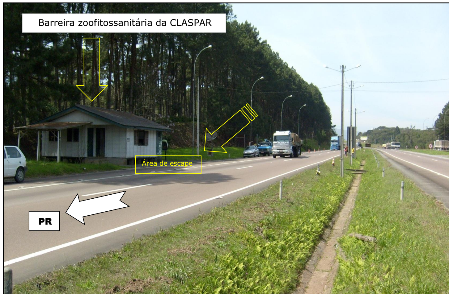
FOTOGRAFIA 3-CT – TIJUCAS DO SUL-PR – PFS FIXO SEBASTIÃO SOUZA SILVA – Estrutura física construída a 50 km da divisa com o estado de Santa Catarina; Sem cobertura externa para abrigar os veículos transportadores abordados; Deficiência agravada nos dias de chuva, pois as cargas de interesse não são fiscalizadas; Sem área de escape com espaço seguro e adequado à interceptação dos veículos transportadores.
