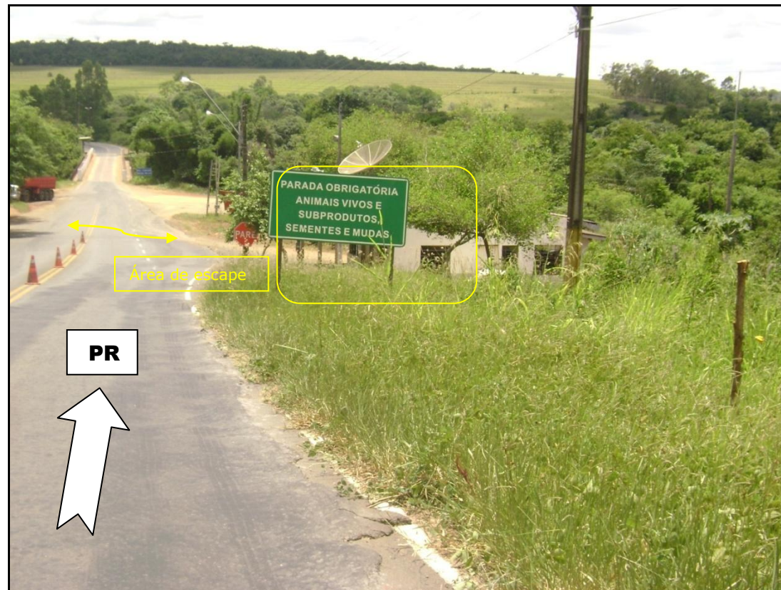
FOTOGRAFIA 1.1-JA – SANTANA DO ITARARÉ-PR – PFS FIXO SANTANA DO ITARARÉ – FOTOGRAFIA À ESQUERDA: Aspectos gerais; FOTOGRAFIA À DIREITA: Sem área de escape com espaço seguro e adequado à interceptação dos veículos transportadores de cargas de interesse.
