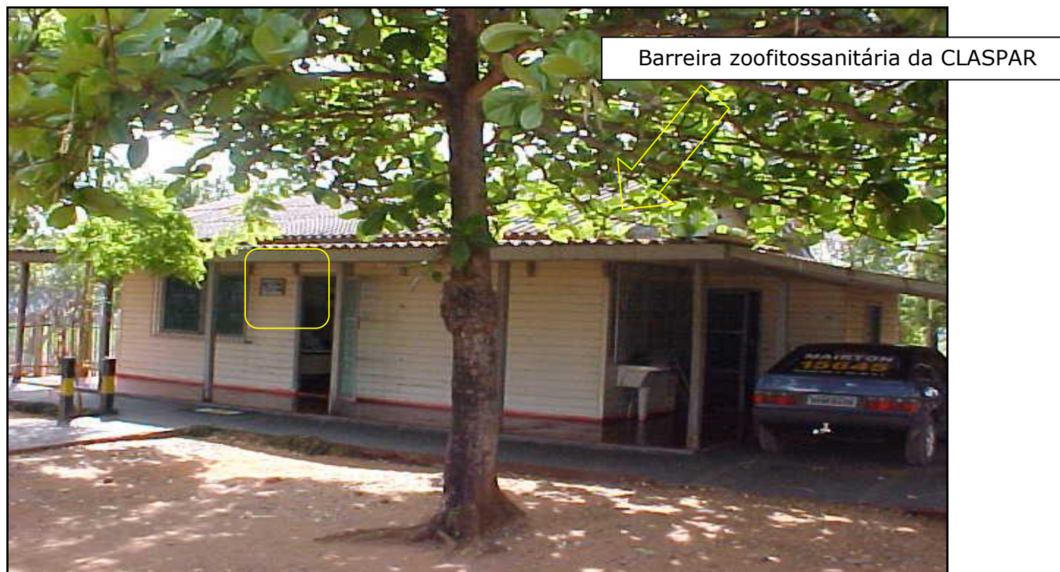
FOTOGRAFIA 1.1-PV – TERRA RICA-PR – PFS FIXO TERRA RICA – Aspecto da estrutura física externa.
