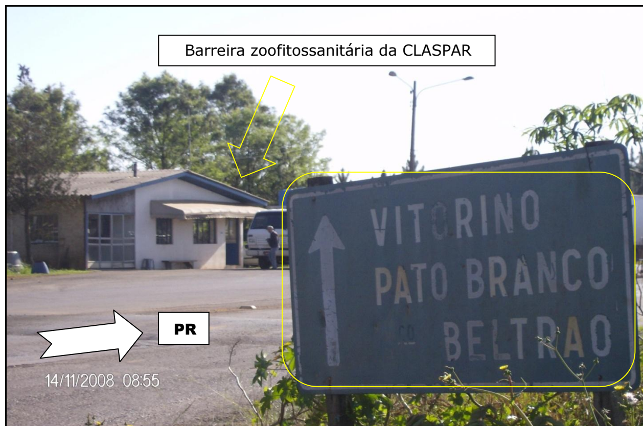
FOTOGRAFIA 1.1-PB – VITORINO-PR – PFS FIXO VITORINO – Aspecto da estrutura física externa.
