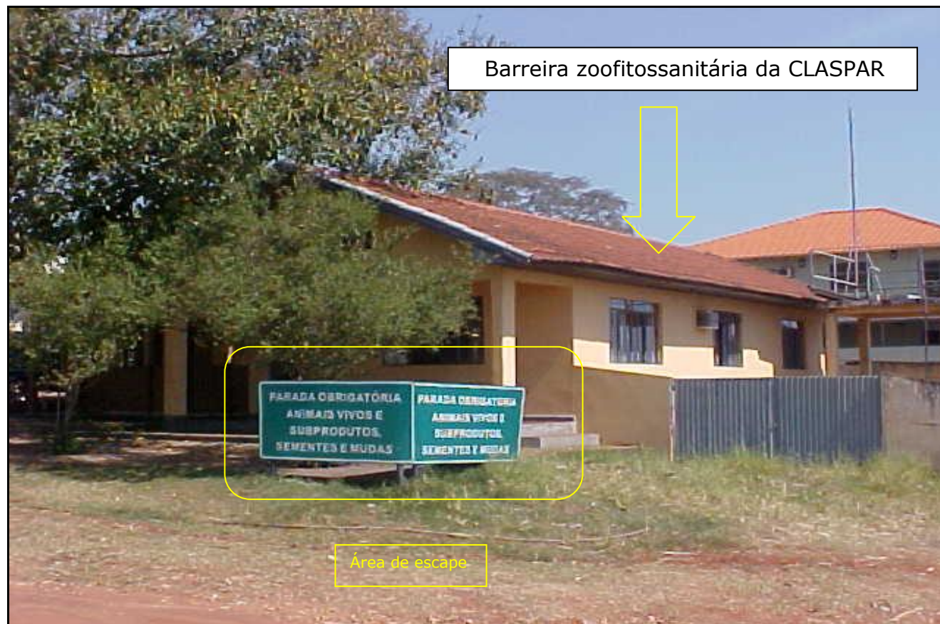
FOTOGRAFIA 3.1-PV – SÃO PEDRO DO PARANÁ-PR – PFS FIXO PORTO SÃO JOSÉ – FOTOGRAFIAS À ESQUERDA E À DIREITA: Aspecto da estrutura física fixa; Aspecto das placas de advertência e de sinalização.
