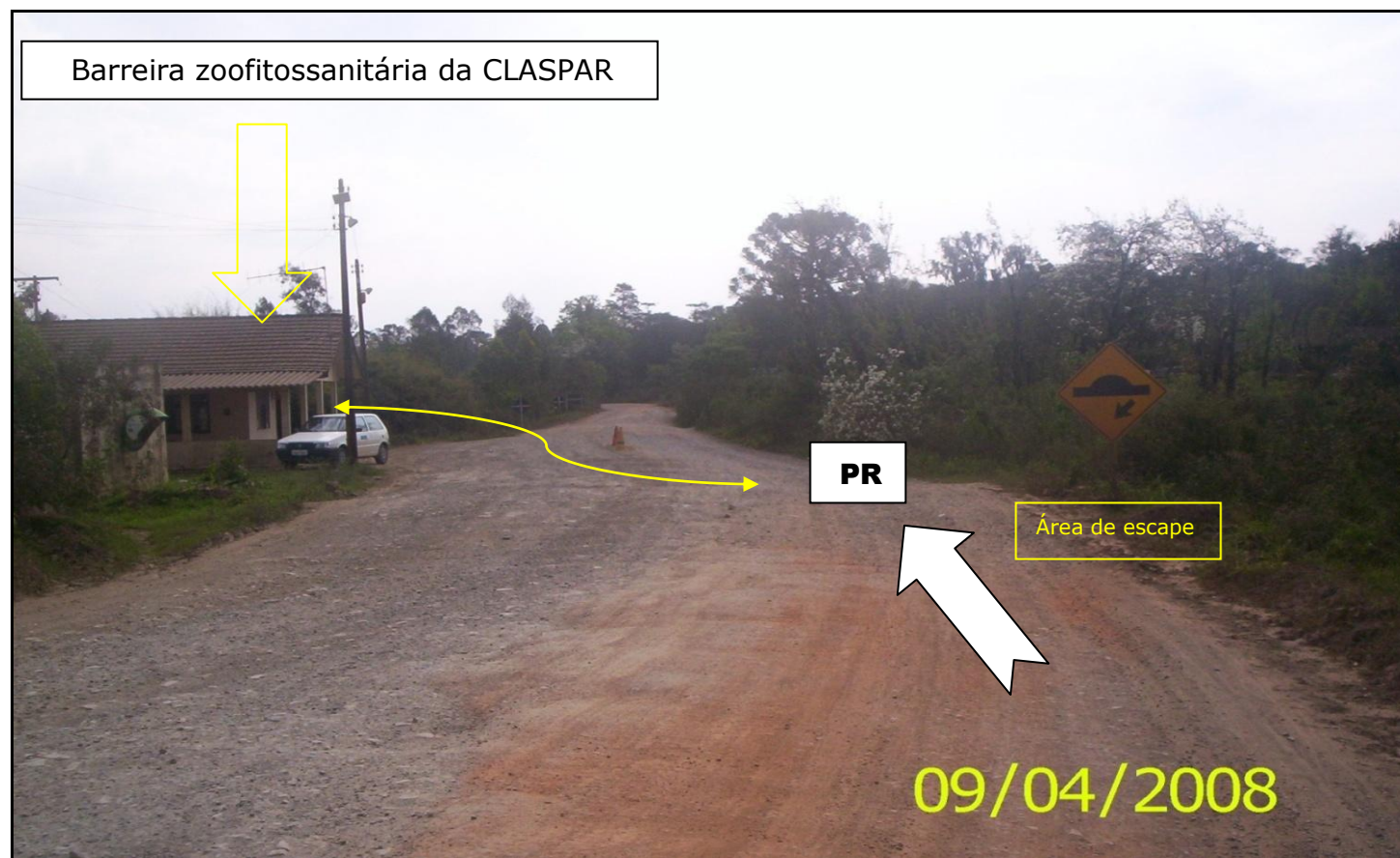
FOTOGRAFIA 2.1-UV – SÃO MATHEUS DO SUL-PR – PFS FIXO DIVISA – FOTOGRAFIAS À ESQUERDA E À DIREITA: Estrutura fixa construída na contramão do trânsito de veículos transportadores de cargas de interesse (animais e produtos de origem animal, vegetais e insumos agrícolas) com destino (ou em trânsito) ao território paranaense; sem cobertura externa para abrigar os veículos transportadores abordados; Deficiência agravada nos dias de chuva, pois as cargas de interesse não são fiscalizadas; Sem área de escape com espaço seguro e adequado à interceptação dos veículos transportadores; Área de escape pavimentada com cascalho.
